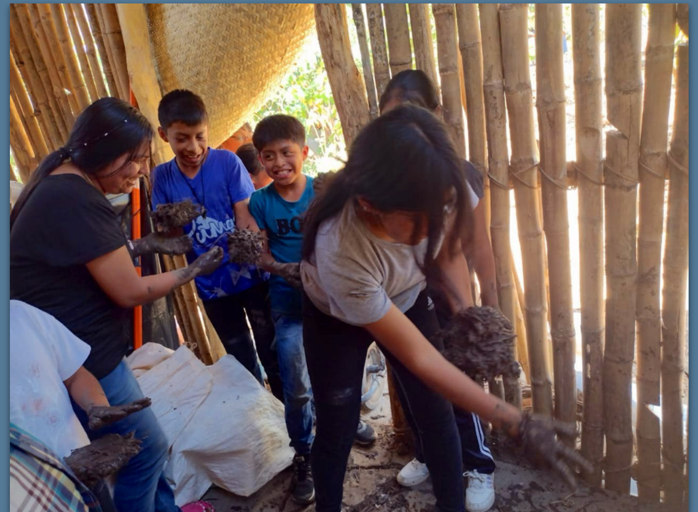
Jóvenes Aprendiendo La Construcción Ancestral De Paredes
